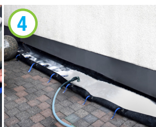
4 Pompage de l'eau sale
