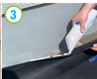
3 Application de la pâte d'étanchéité
